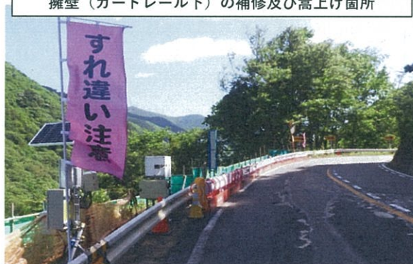
擁壁（ガードレール下）の補修及び嵩上げ箇所
