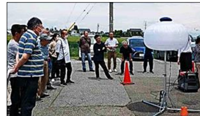
発電機、投光器の試運転
