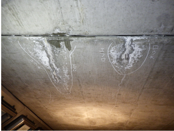
〔継手部：顕著な漏水状況〕
