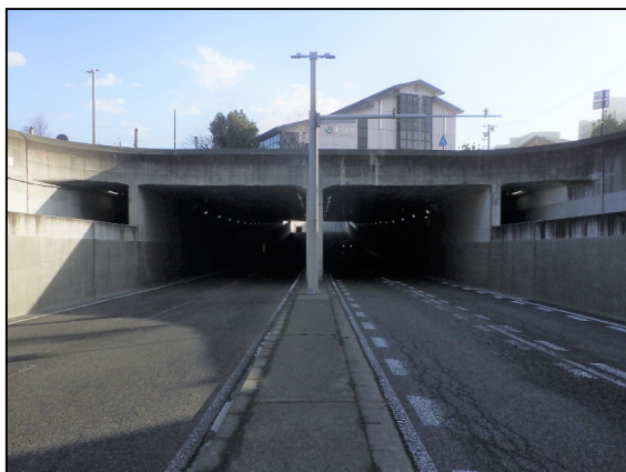
北松本架道橋（1999年竣工）
