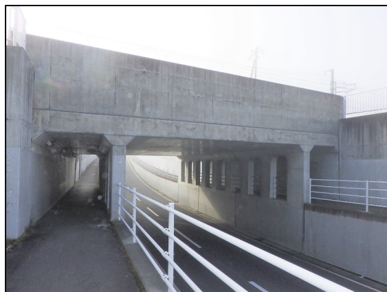
合庁南架道橋（2002竣工）
