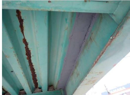
床版の腐食は橋面からの漏水が原因と推定されたことから、橋面防水層の設置及び舗装打換えを実施した。
