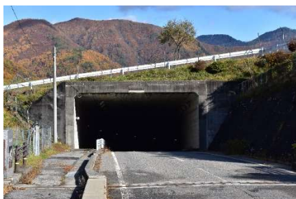
写真-2 雪見ヶ原トンネル全景
