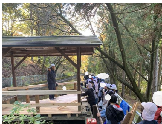
(東屋補修作業の様子)
