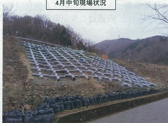
4月中旬現場状況
