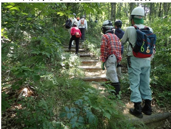
階段状に設置した擬木
