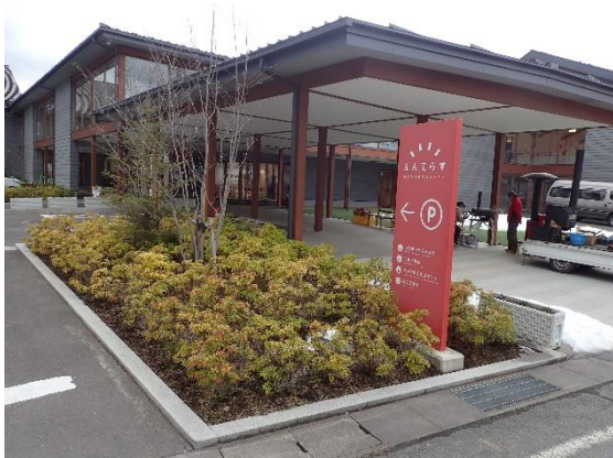
木造施設の外観
