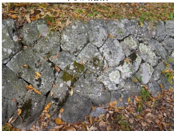
空石積み工法
