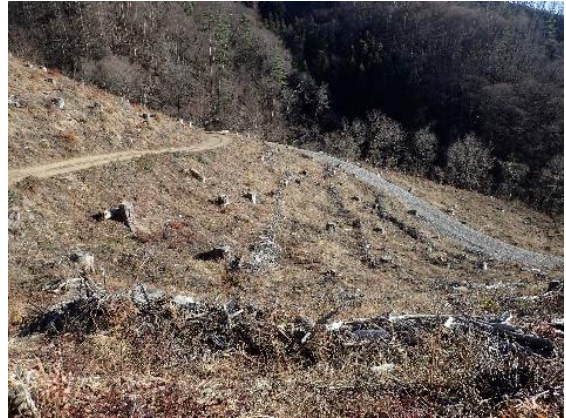
作業現場の状況
