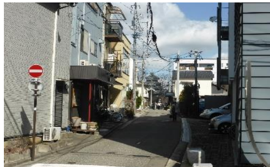
電線類による景観の阻害
