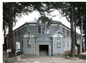
旧松本高等学校（本館）
