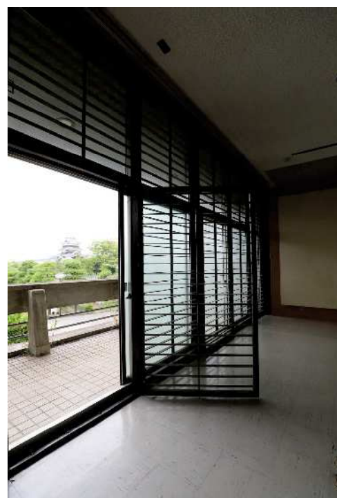
講堂西面の窓格子
