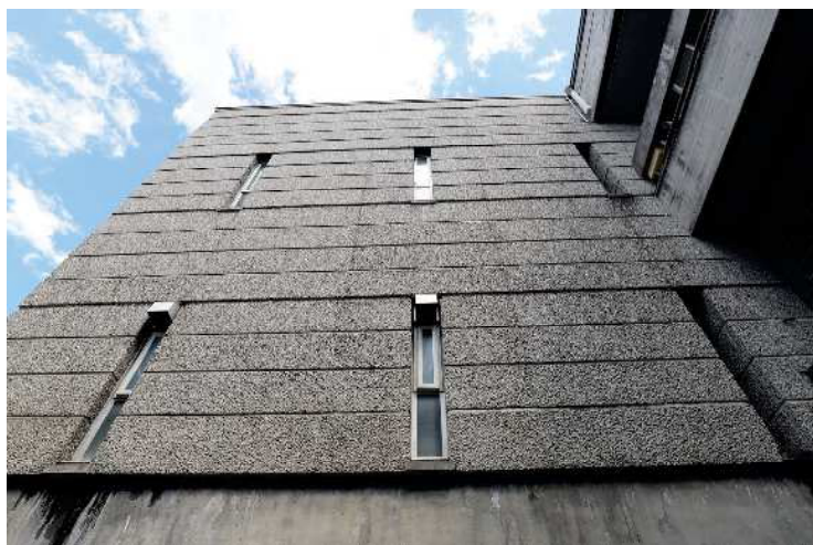
トイレの換気フードは窓と併せて配置
