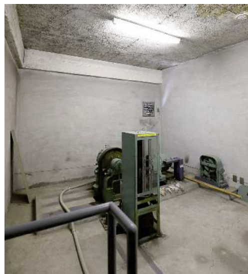
塔屋機械室(エレベーター機械室)
