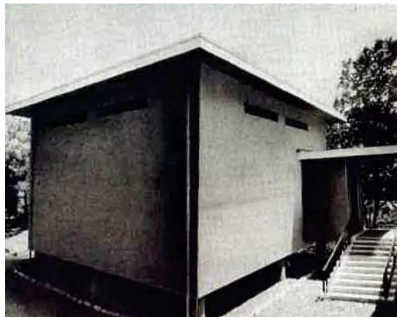
『重要民俗資料収蔵庫のしおり』より、収蔵庫外観
