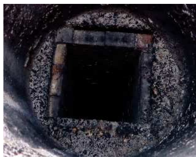
煙突(上部から)
