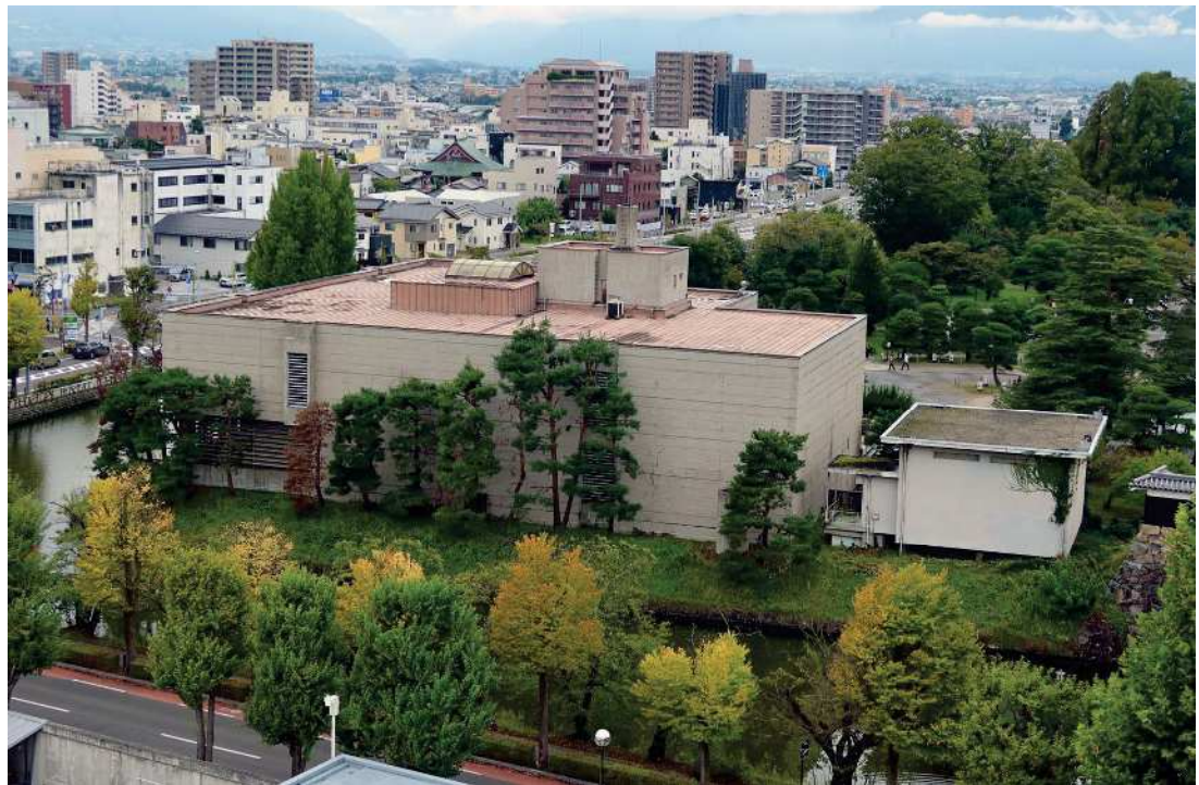
4.市役所屋上から
