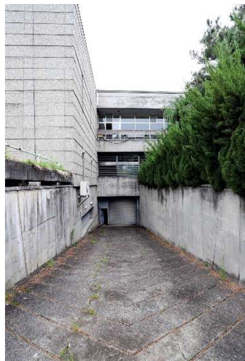
搬入口スロープ
