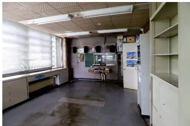
1階事務室(奥のガラス小窓が旧切符売り場窓口)
