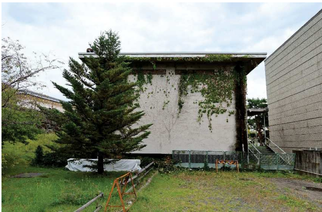
23.重要民俗資料収蔵庫 外観(西面)
