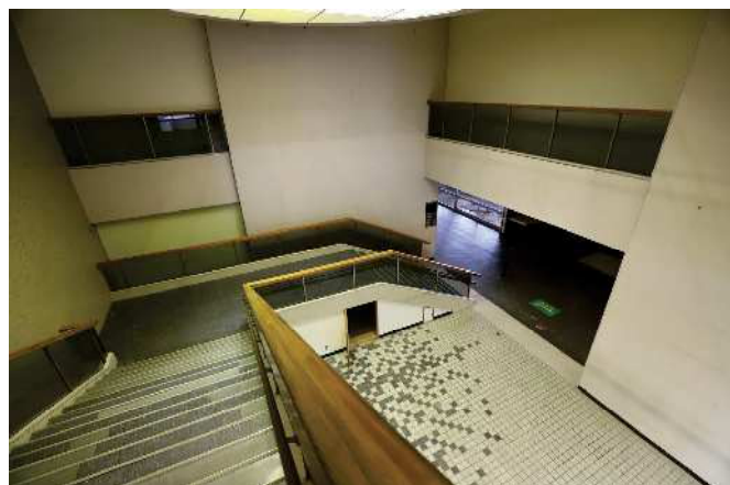
2階 階段ホールから見下ろし
