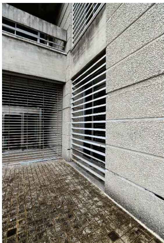
外装(PCパネル・板型枠打放コンクリート・鉄格子)
