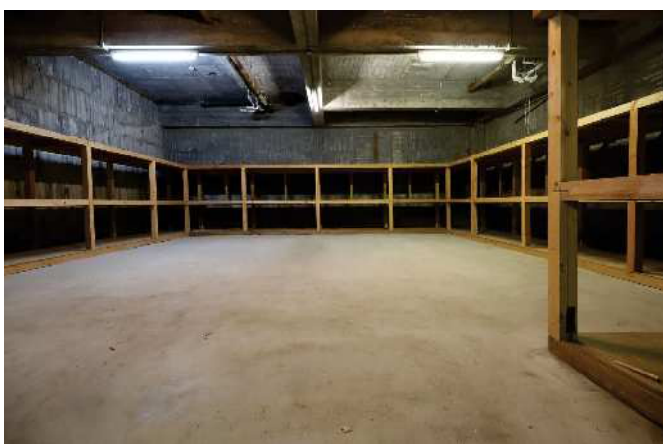
地階 倉庫(拡張した部分)
