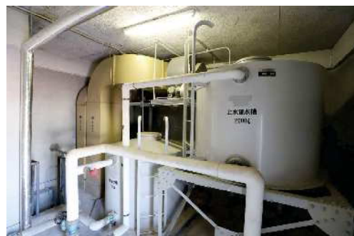
塔屋機械室(水槽室)
