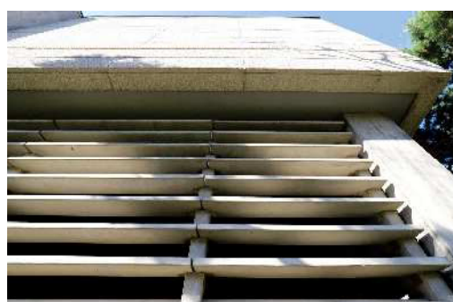
PCルーバー及び、壁PCパネル下端
