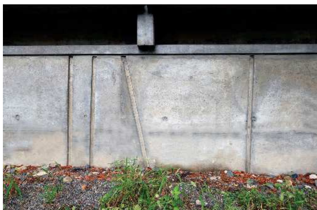
化粧目地打放コンクリート
