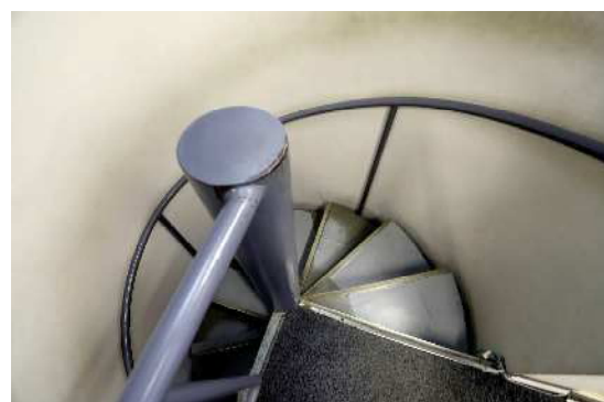
事務室ー図書研究室のらせん階段上部
