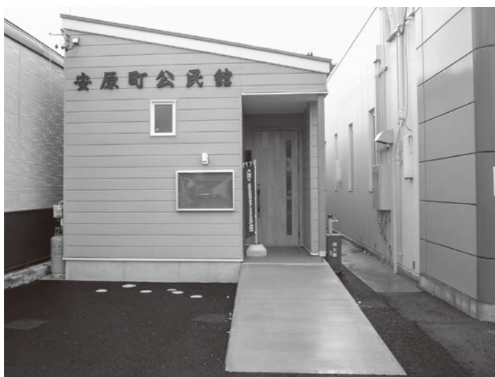
「安原町公民館」の文字は古い建物から外して取付
