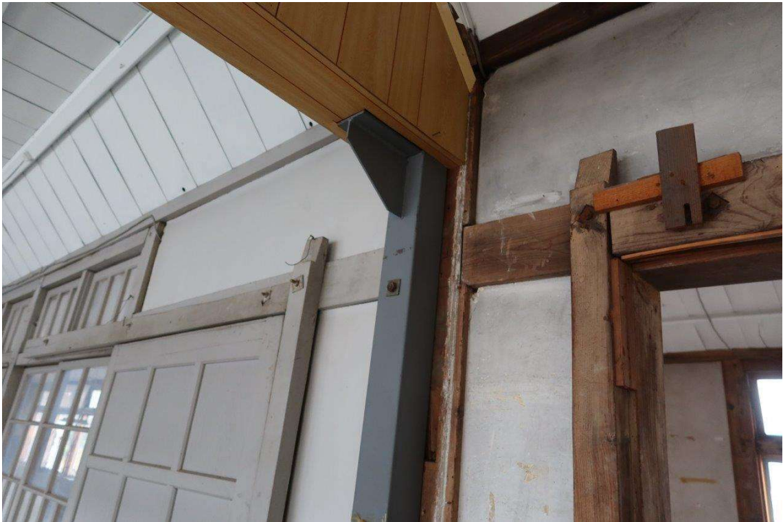
2階廊下鉄骨にて補強された部分いつの時代のものかは不明
