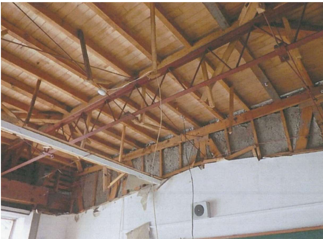
教室 1 階内部 床を支える鉄骨梁（解体工事写真より）
