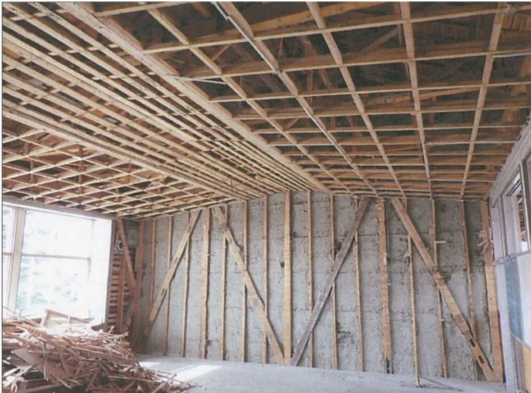
教室 2 階内部 天井下地、壁筋交い、間柱の状態（解体工事写真より）
