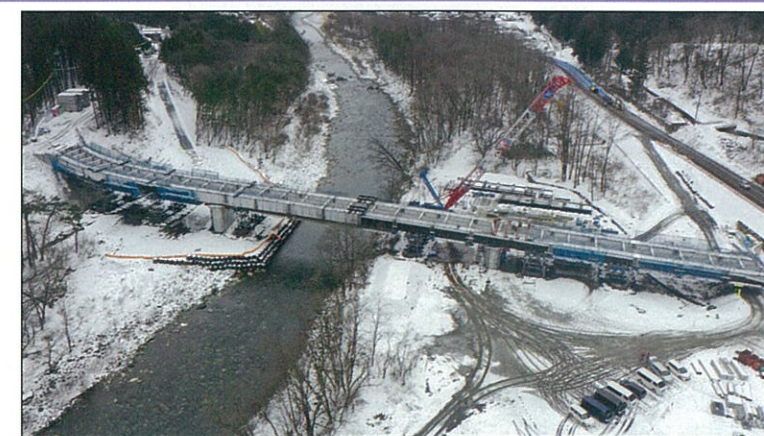
上部工架設の様子(R7.3.6時点 上流側から)
