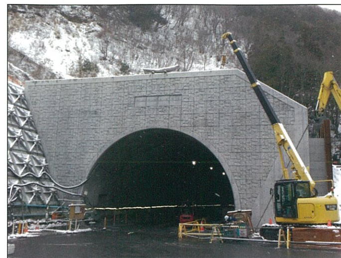
起点側(稲核ダム側)坑口
