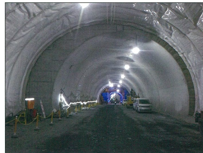
覆工コンクリートの打設が進むトンネル坑内
