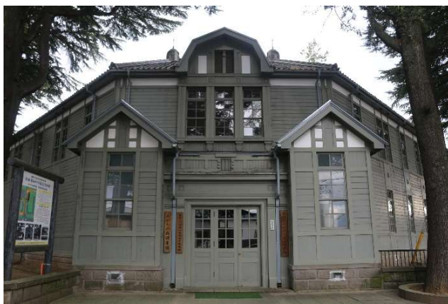
旧松本高等学校本館（あがたの森文化会館）
