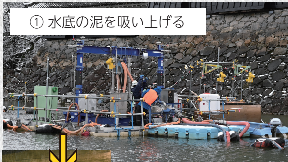
② 吸い上げた泥水をホースで処理ヤードに送る
