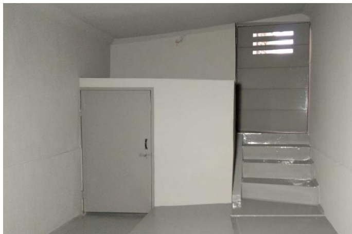
既存送水設備(ポンプ室)改修(防水塗装)状況
