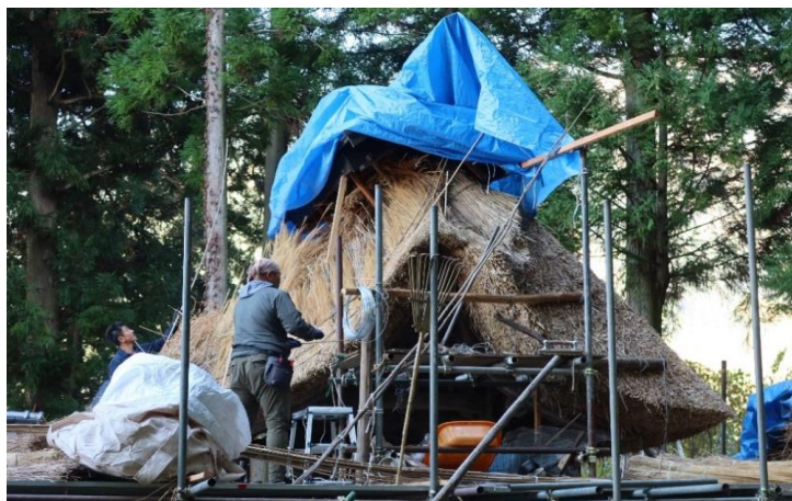
松本市重要文化財 南方諏訪神社本殿 屋根葺き替え
