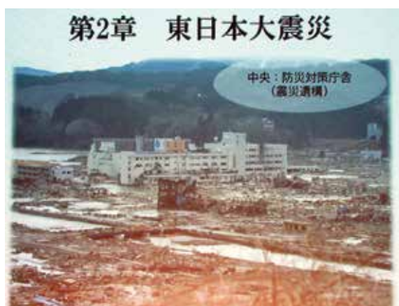
震災遺構（防災対策庁舎）
