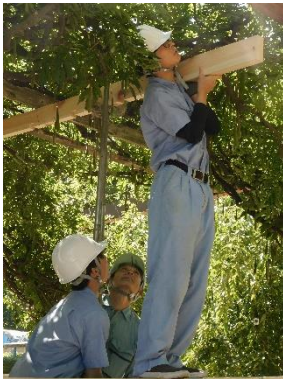
修繕を行っている様子
