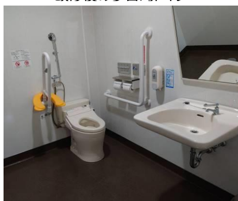
改修後の多目的トイレ
