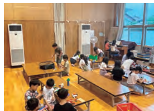
エアコンが設置されている鎌田児童センターの遊戯室
