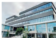
春日部市役所外観
