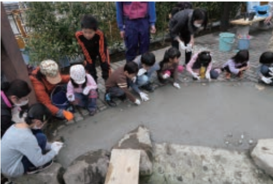
改修工事ではワークショップも。子どもたちが好きな石を持ってきて埋めて、洗い出し仕上げの体験
