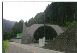
三本松トンネル側の坑口
