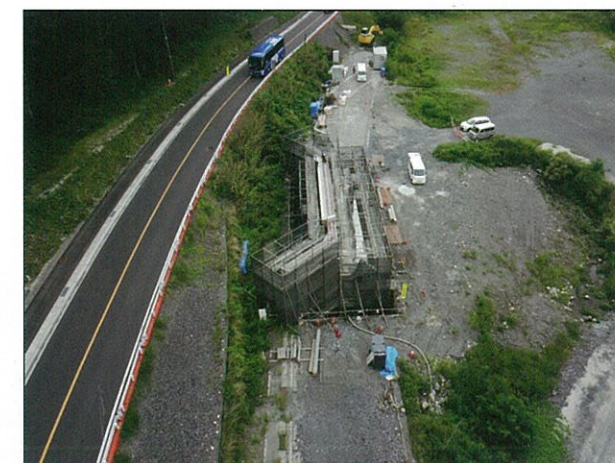
施工中のA1橋台
