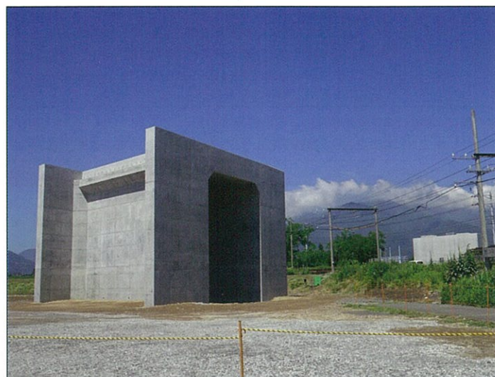
(手前)和田地区側A1橋台 (奥)波田地区側A2橋台
