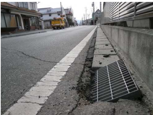
側溝の破損
