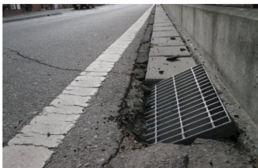
側溝の破損
