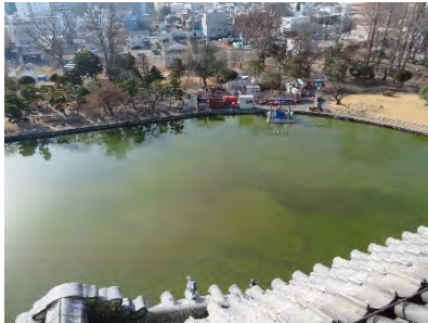
浚渫前の内堀
