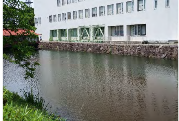
東総堀北半部南側(北東から)
