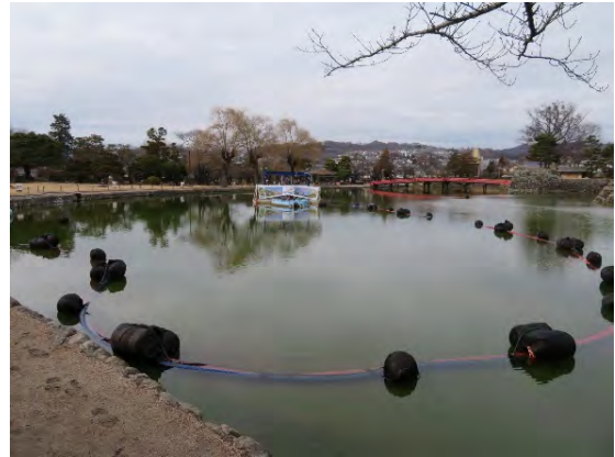
水底土砂ポンプ浚渫工法による浚渫の様子（令和2年度実証実験時）
