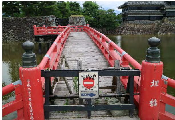
本丸西面石垣、埋橋、管理用門
