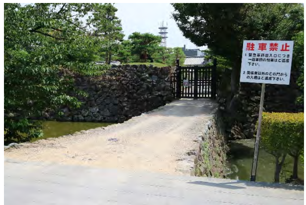
北裏門土橋、管理用門（北から）
