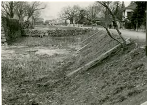
図版42 改修中の北外堀北面土坡 昭和31年(1956年)
