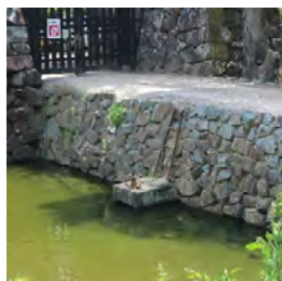
水門(北裏門土橋)
