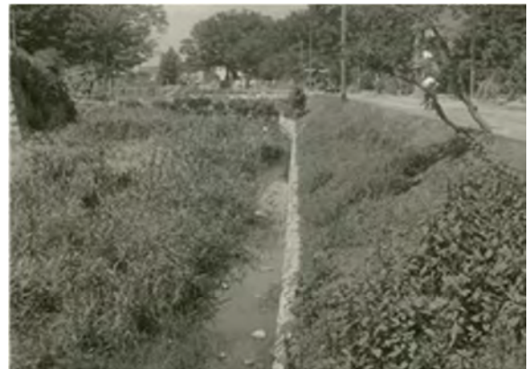
図版43 北外堀北面土坡の裾石垣 昭和31年(1956年)
