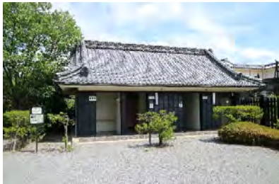
トイレ(二の丸御殿跡東)
