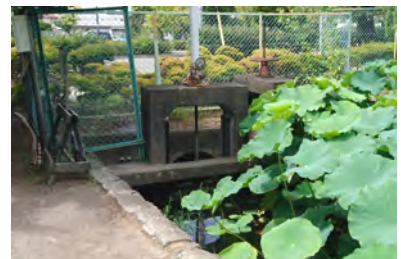
堀水排水口(北西外堀西端)
