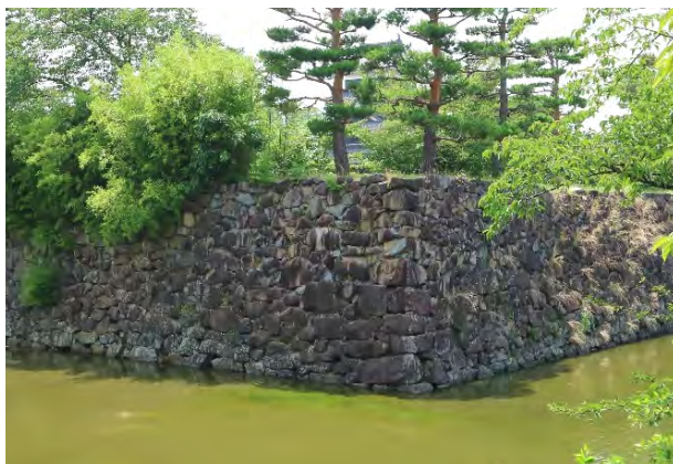
折廻し やくら 橋 台石垣 写真図版2（本丸②）
