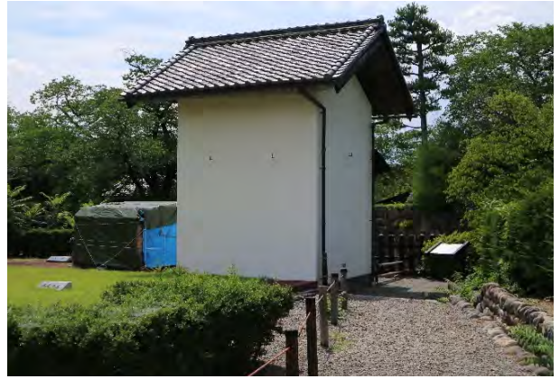
御金蔵(土蔵 東から)
