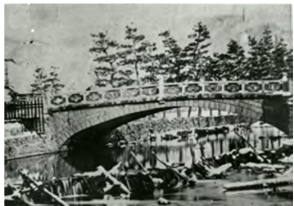
図版35 大手門石垣の石を転用した千歳橋 (時期不詳)
