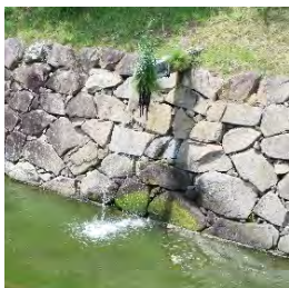
地下水投入口(北外堀)
