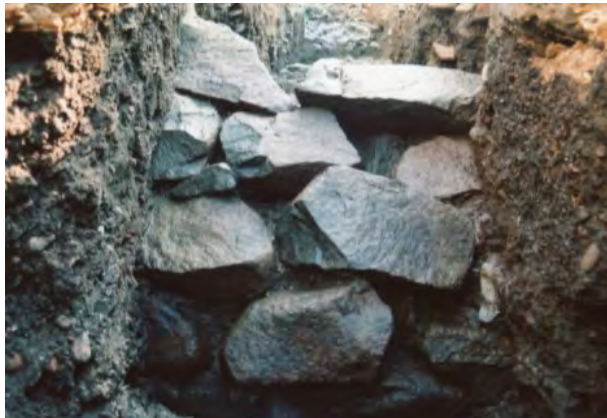
南外堀三の丸側の石垣(試掘調査時)
