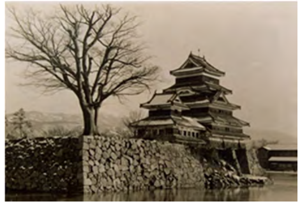
図版23 埋門北側石垣の崩落 昭和5年(1930年)
