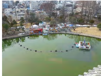
浚渫中（浚渫の様子）
