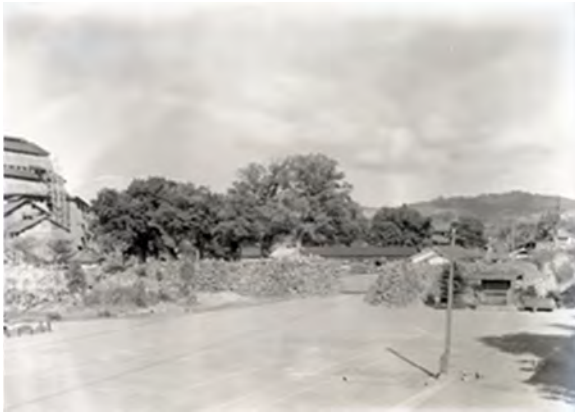
図版36 天守昭和修理時の黒門付近 昭和25年から30年(1950年から1955年)
