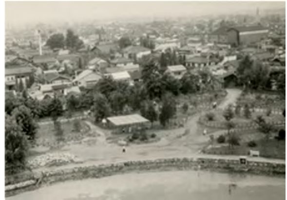
図版39 改修中の内堀南・西面石垣 昭和31年(1956年)
