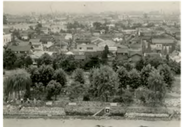
図版41 改修中の内堀南面石垣と植樹 昭和31年(1956年)
