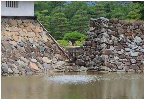
水門跡（月見櫓脇 西から）
