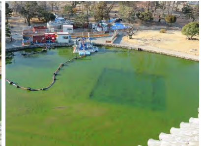
浚渫後の内堀
