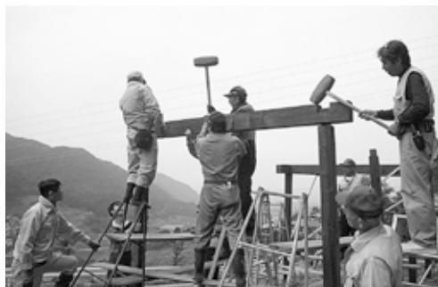
寺所ロータリーの藤棚建設
